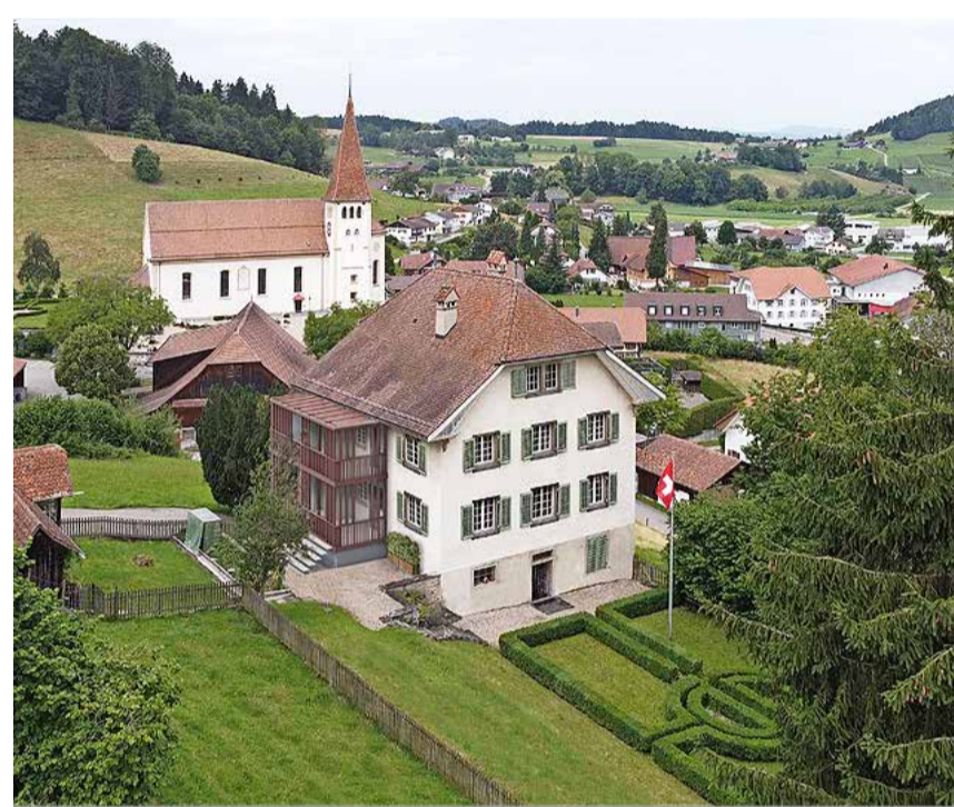
Das Pfarrhaus in Altishofen wird für 1,4 Millionen Franken umgebaut. Foto zvg
