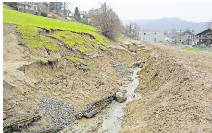
Die Böschungspflege soll in Reiden neu reglementiert werden: Im Bild der Sertelbach, als 2021 das ungesicherte Ufer abrutschte. Bild: zvg
