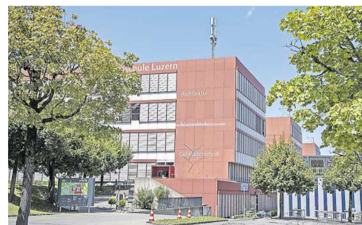
In den Gebäuden der Hochschule Luzern in Horw war früher das Technikum untergebracht.
