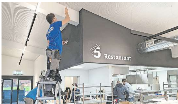
Handwerker arbeiten am Badi-Restaurant während der ersten Sanierungsetappe.
