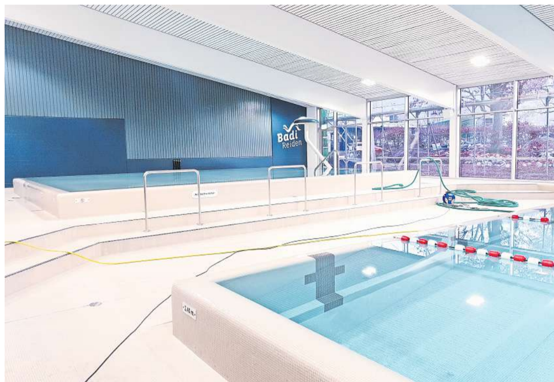
Blick in die Badi Reiden während der Sanierungsarbeiten.
