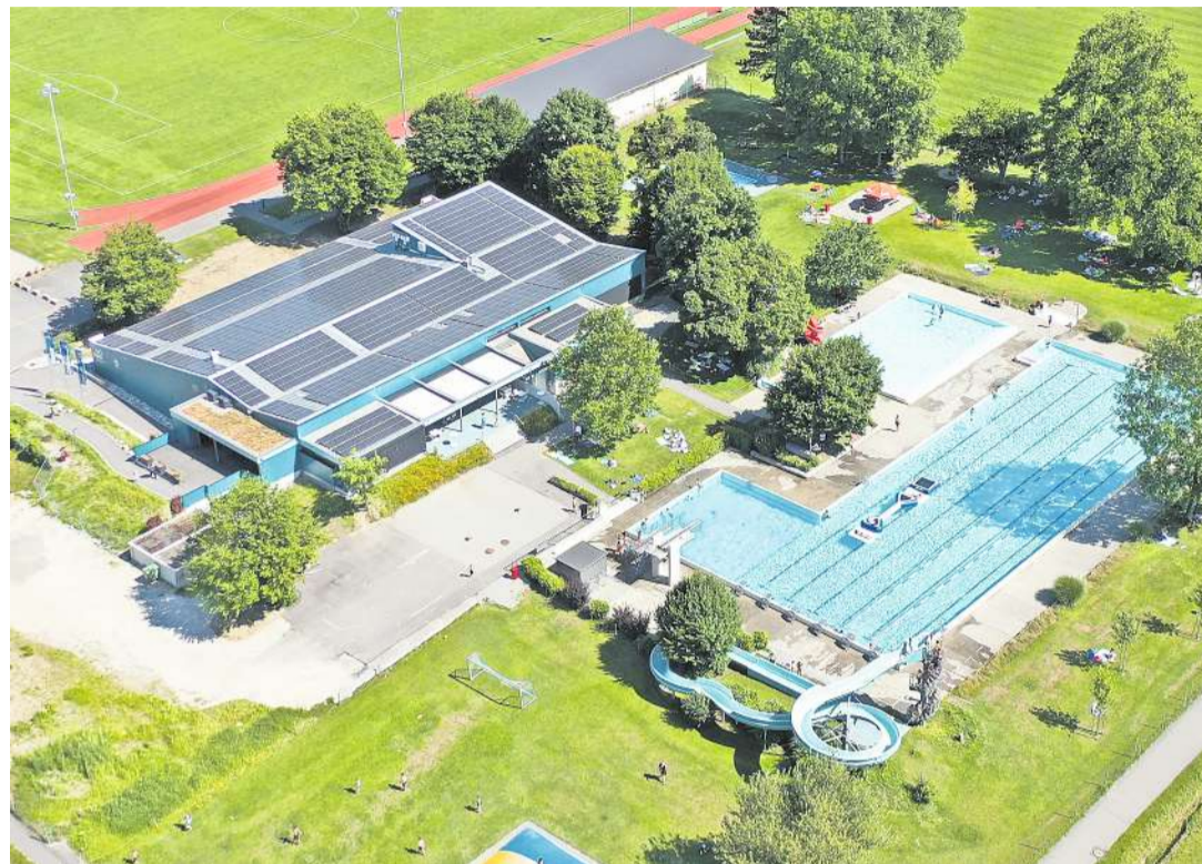
Der Solarstrom vom Dach der Badi Reiden könnte 41 Haushalte versorgen.
