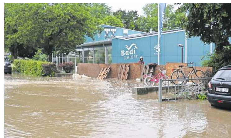
Die heftigen Regenfälle richteten am 24. Juni einen grossen Schaden im Technikraum der frisch sanierten Badi Reiden an. Bild: Raphael Nadler
